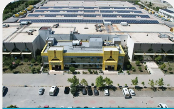
PTT-İstanbul Hadımköy / Dağıtım Merkezi
