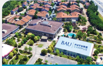
BAU Kampüs Eyüp
